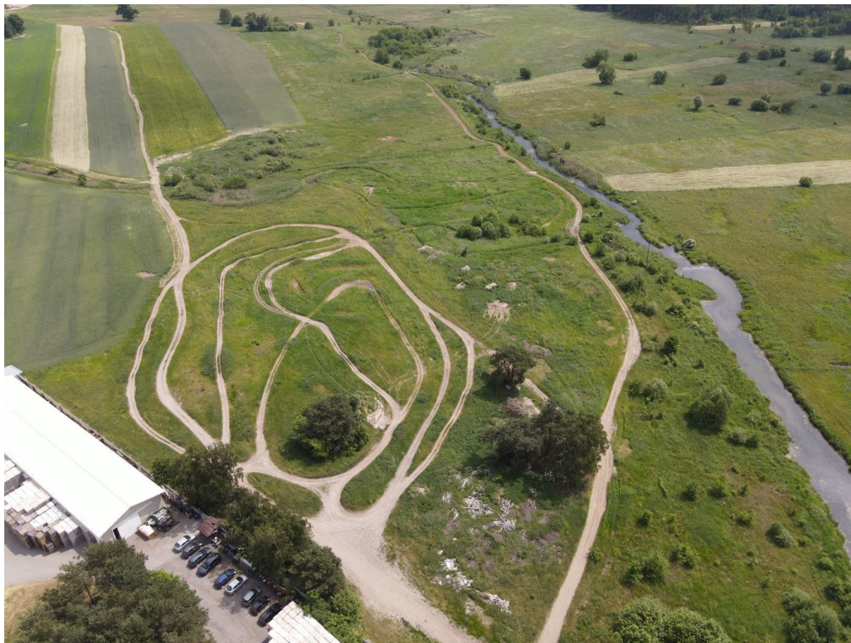
Zdjęcie 4: Zdjęcie przedstawiające tereny pod budowę nowej oczyszczalni. Źródło: opracowanie własne
