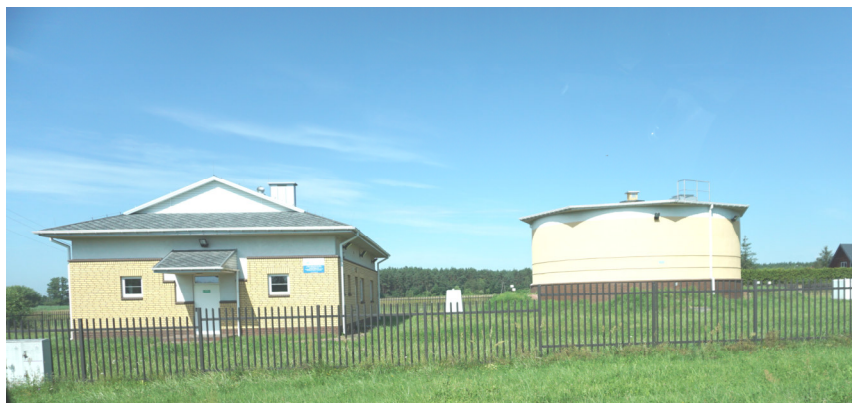
Stacja uzdatniania wody
