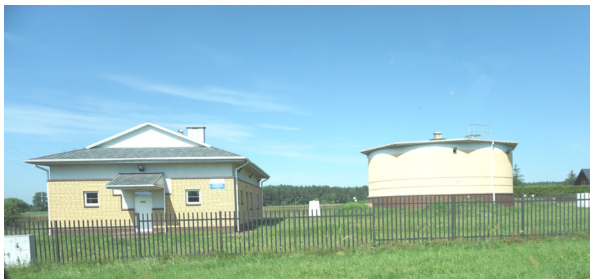
Stacja uzdatniania wody
