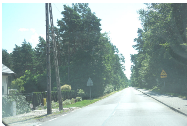
Roślinność wzdłuż drogi powiatowej – ul. Gen. Fr. Żymirskiego - poza terenem zabudowy
