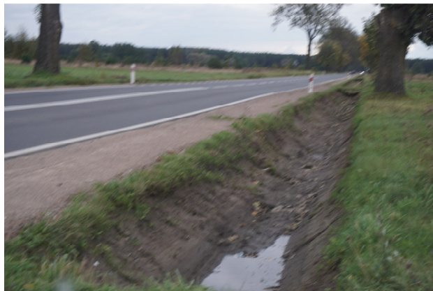
Rowy odwadniające wzdłuż drogi nr 636
